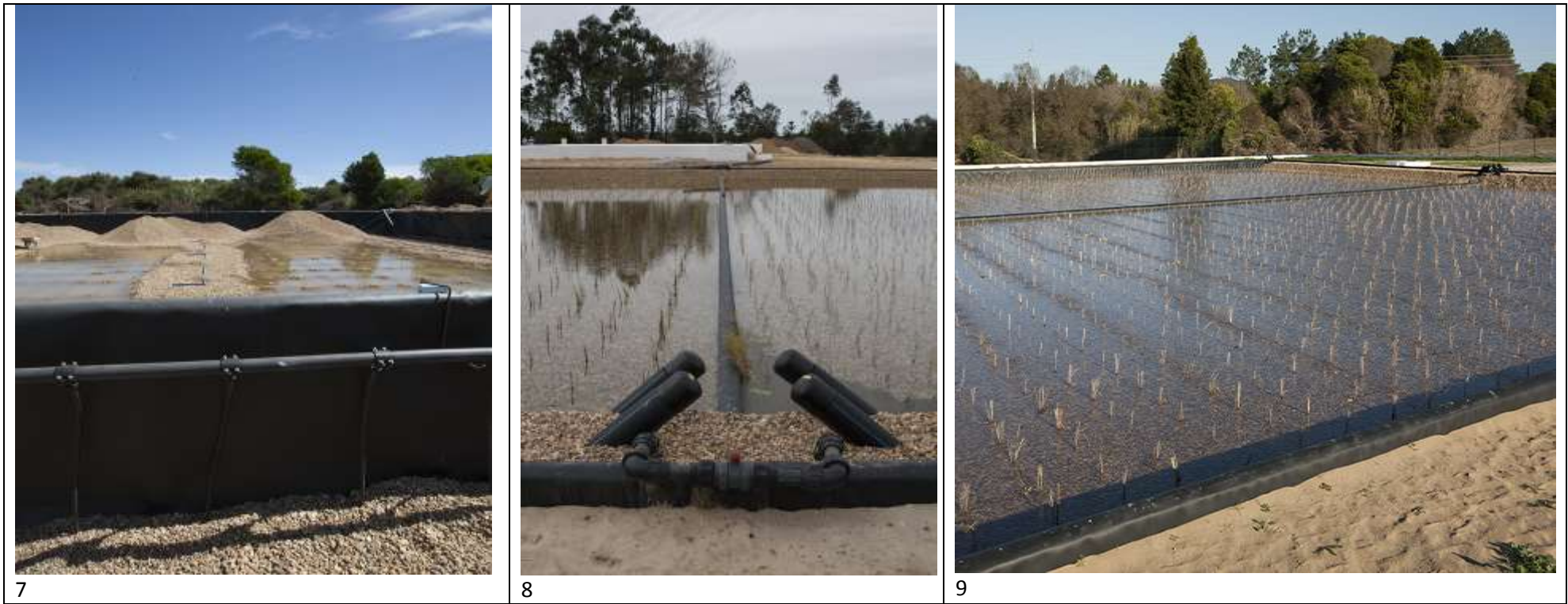
Рис. 3. Этапы строительства горизонтального ФОС с подповерхностным потоком и принудительной аэрацией.
